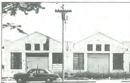
Prédio onde funcionou a primeira fábrica da Tortuga (1954)
