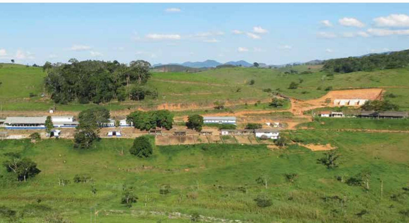
Instalações do Complexo Multiusuário de Bioeficiência e Sustentabilidade da Pecuária em Coronel Pacheco, MG.
