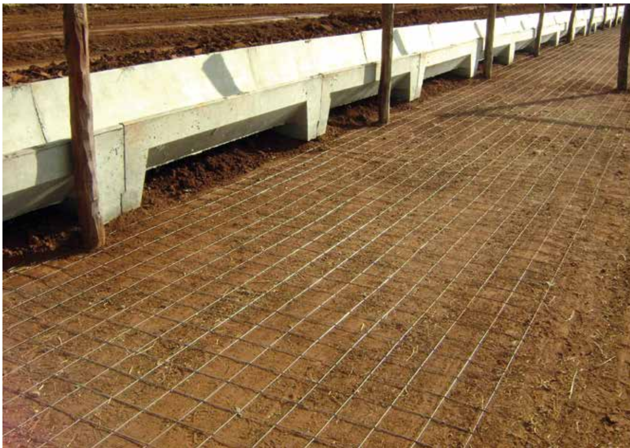
Trama de ferro utilizada no alicerce da área concretada do piquete de confinamento.
